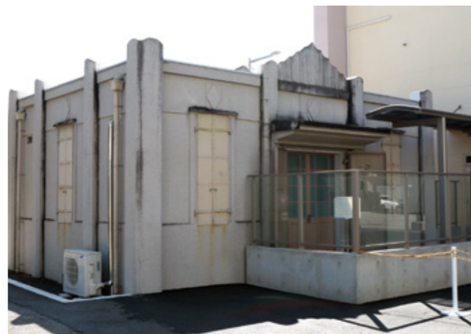
水晶庫の外観。柱は六角で、配置されたひし形のレリーフは水晶を、正面上部の装飾は水ヶ森を表しています。
